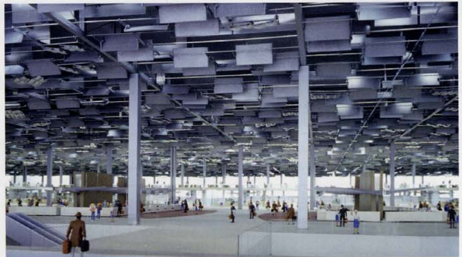
11 Beim Großprojekt Changi Airport in Singapur sorgen 919 lichtlenkende Deckenelemente aus Aluminium für die effiziente und blendfreie Verteilung des natürlichen und des künstlichen Lichts.
